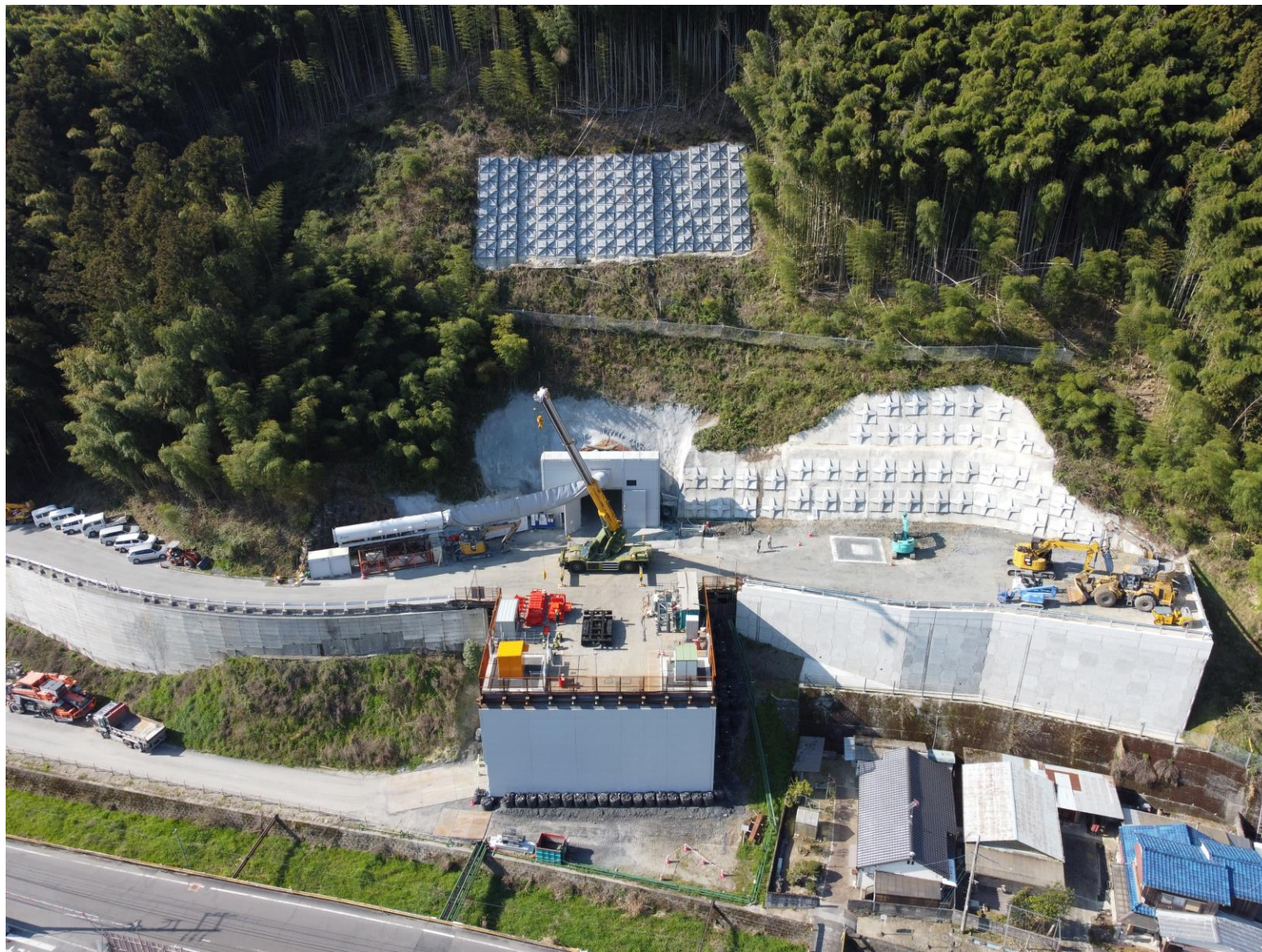
①小瀬川付近より岩国トンネル方向を撮影 <R5. 3月末現在の掘進長 約153m>
