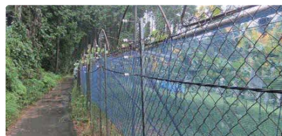
侵入防止柵の設置
