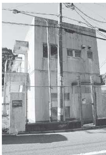
瀬田、関ヶ浜地区の浄水施設
