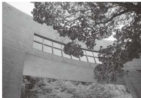
庁舎北側通路の雨漏り工事
