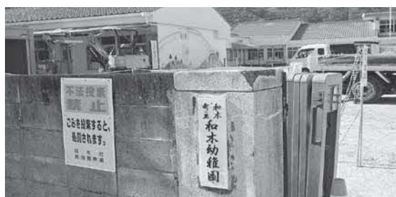
解体が必要とされる旧幼稚園
