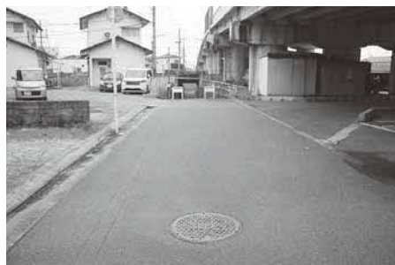
大規模下水道管路調査が行なわれる道路
