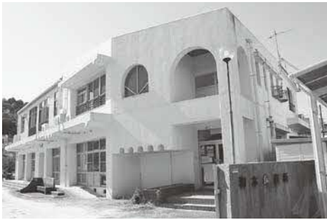
解体を待つ旧保育所
