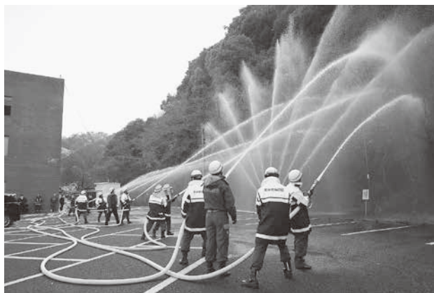
一斉放水の様子
