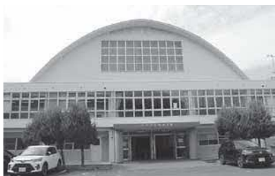
改修が終わった体育館
