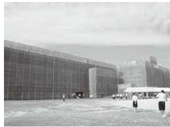
改修中の中学校校舎
