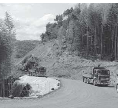
工事が進む県道蜂ヶ峯公園線
