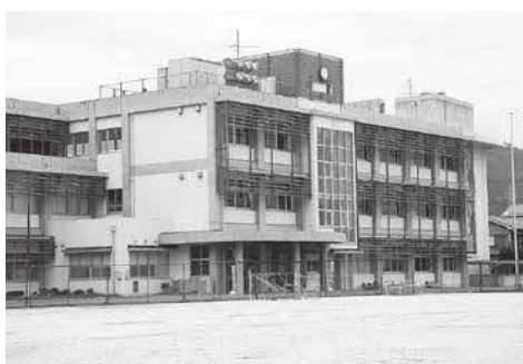
外壁改修が始まる中学校校舎
