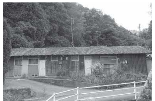
解体が決まった町営住宅
