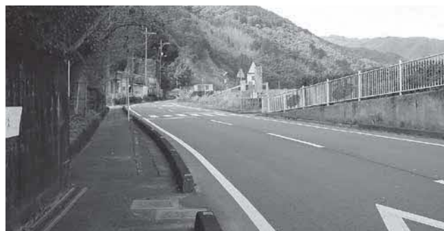
道路拡幅工事のため地質調査中
