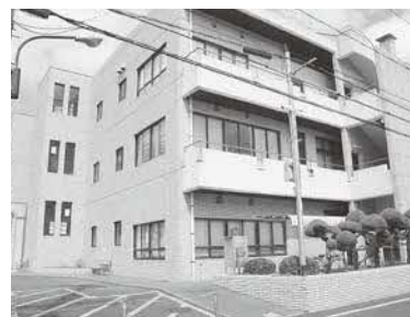
改修されるコミセン外壁
