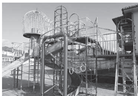
駐車場になったため遊ぶことができない総合遊具
