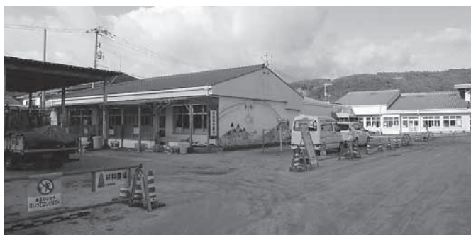
工事により臨時駐車場になっている旧幼稚園
