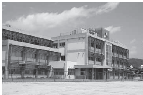
和木中学校の校舎外壁を調査・改修予定
