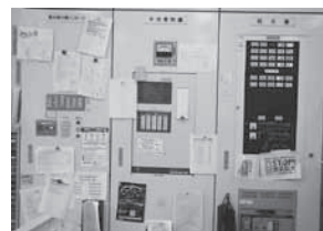
文化会館空調整備改修
