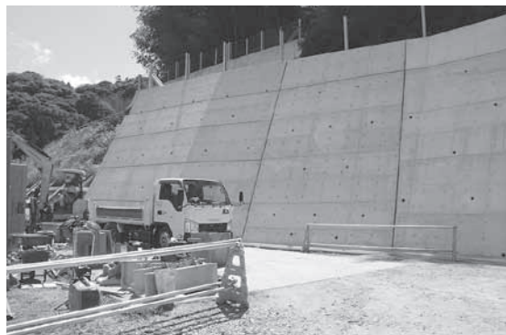
斜面を保護し水害から守る急傾斜地対策工事
