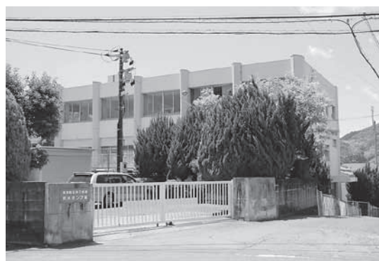
老朽化し改築が必要な和木ポンプ場
