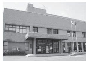
文化会館外壁調査
