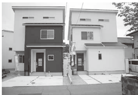
町内の新築住宅
