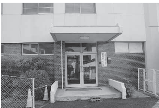
供用開始から47年 下水道ポンプ場
