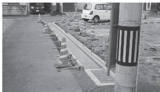
和木3丁目の町道改良工事
