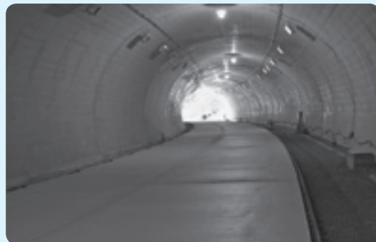
和木トンネル 平成20年2月供用開始予定
