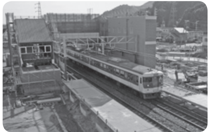
工事は着々と進行しています
