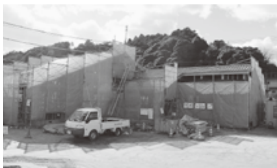
建設中の放課後教室
