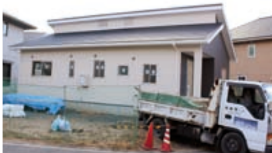
完成間近の警察官用町営住宅
