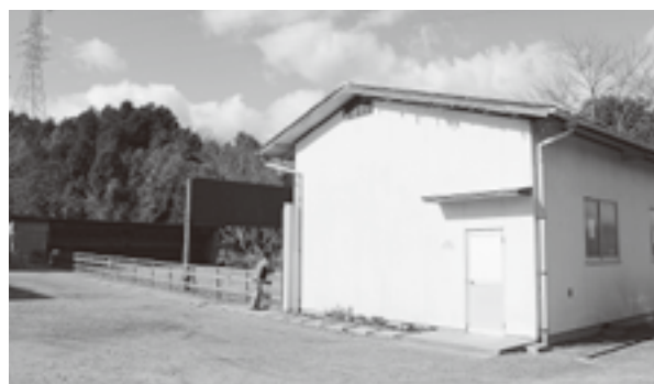
改修が望まれる弓道場
